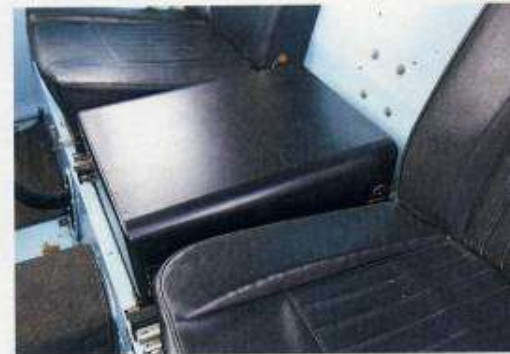
La batterie est placée dans un coffre spécial à la place de l'assise centrale.
