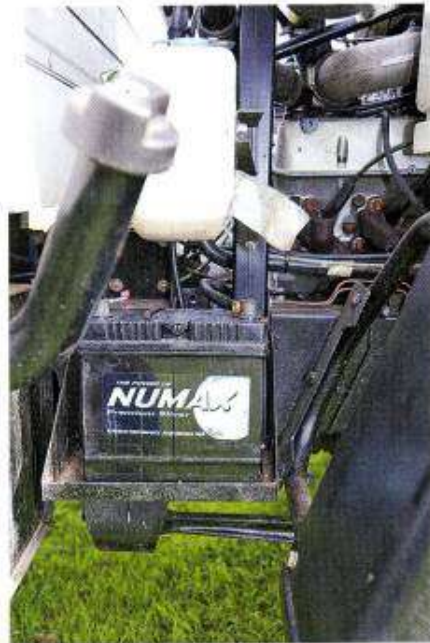
La batterie est quant à elle placée au plus bas, contre le montant du châssis.
